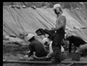
①土を掘る、掘ったら箕でベルトコンベアへ
