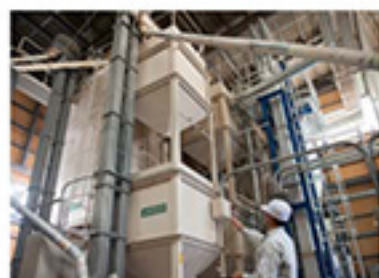
精米機 原料米はすべて自社精米で、 年間120トンの玄米を精米
